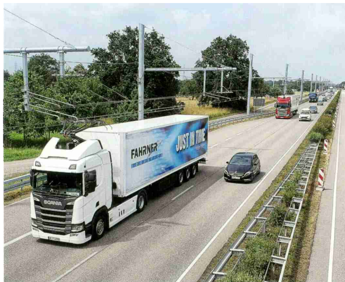
Le troisième tronçon d'essai électrique se trouve près de la frontière française.
